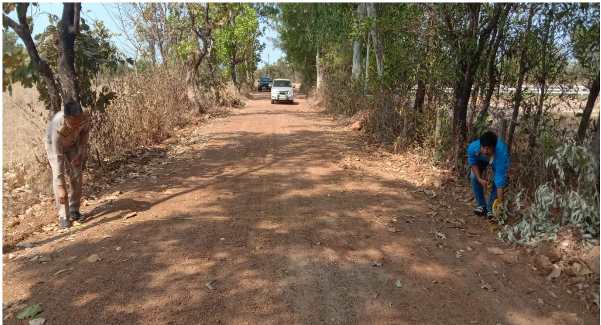
โครงการปรับปรุงถนนลูกรัง หมู่ที่ 13 หมู่ที่ 4 หมู่ที่ 8
