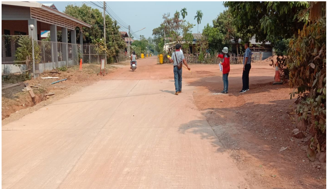
โครงการก่อสร้างถนน คสล. หมู่ที่ 6 บ้านโคกสะอาด
