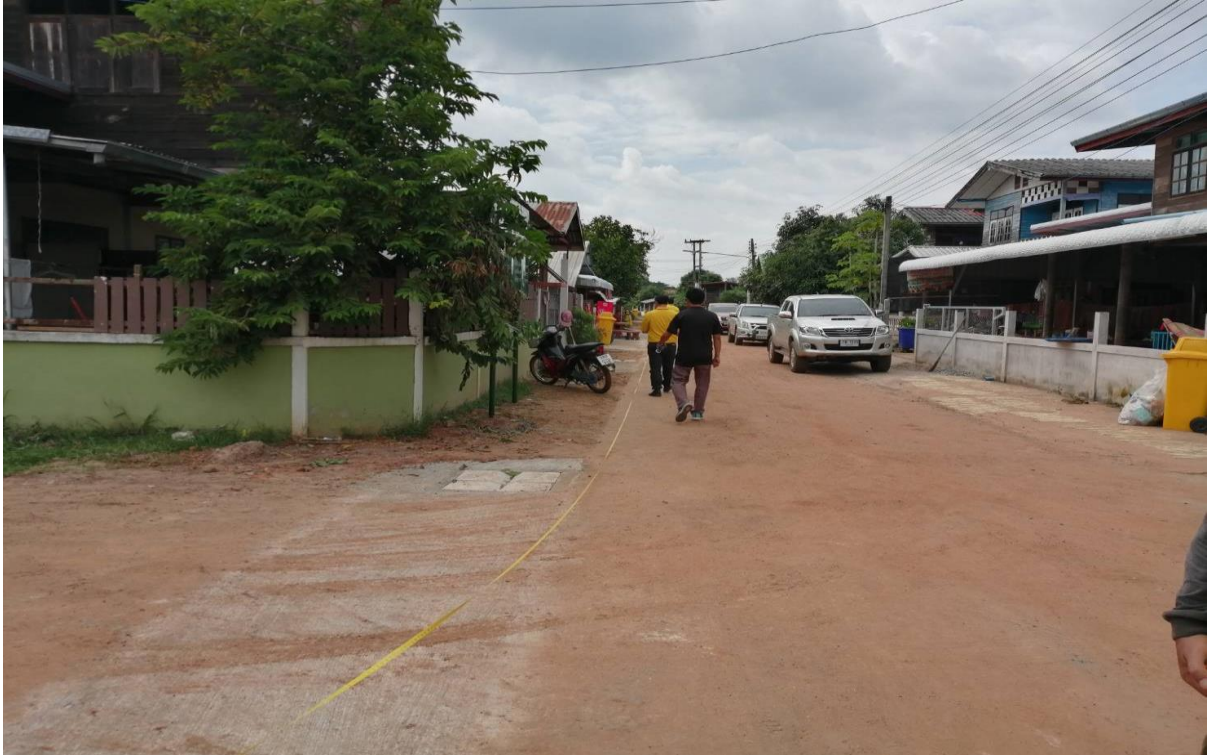
โครงการวางท่อระบายน้ำ คสล. หมู่ที่ 5 บ้านปะแต้
