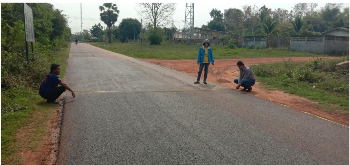
โครงการก่อสร้างถนนลาดยาง หมู่ที่ 14 บ้านแร่
